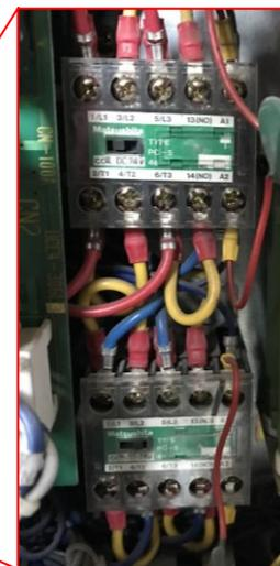
写真3 ブレーキ回路内電磁接触器
